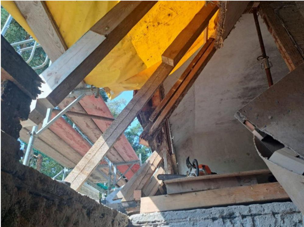
*Abbildung 1: Dachöffnung und Mauerabtragung während der Schwammsanierung, August 2024. Bild: Nadja Grintzewitsch*
